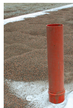
Vamzdis išsikiša virš žemės.
