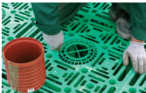
Išpjauamos apsauginės grotelės modulio viršuje ir padaroma \varnothing 200 mm anga.
